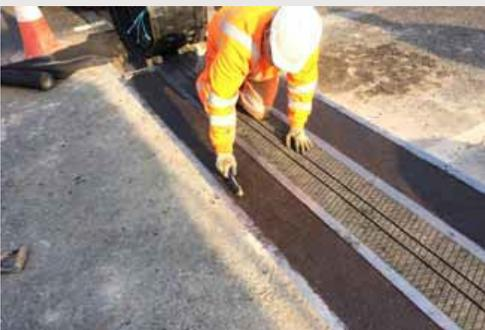
*Imagen de la junta de expansión del puente T-Mat*
